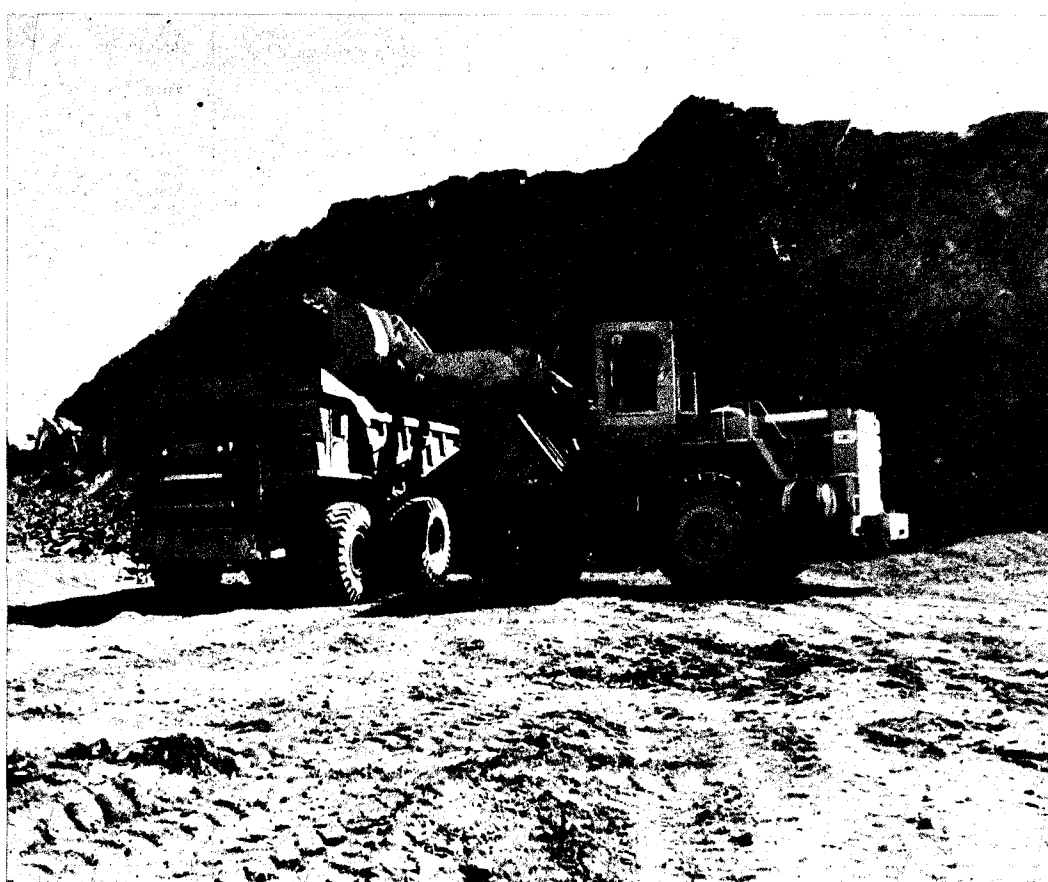
Arranque, carga y transporte en el desmonte previo de la corta de Aznalcollar
