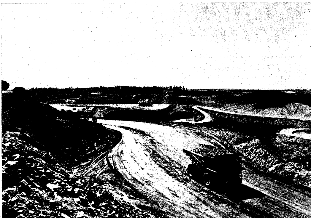
Vista parcial del desmonte previo del criadero
