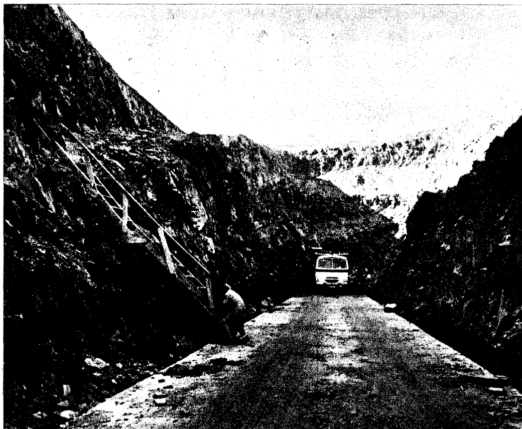
Excavación del canal de derivación del río Agrío
