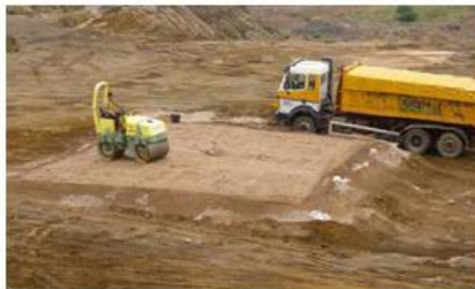
5. Compactación de lo finos
