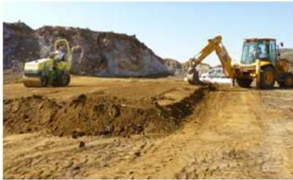
1. Nivelación del terreno al 3% de pendiente
