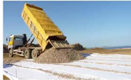
2. Geotextil y capa de gravas.
